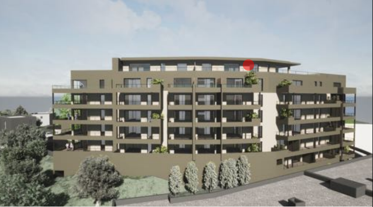
Situation sur façade Est
