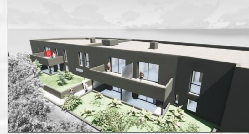
Situation sur façade Ouest
